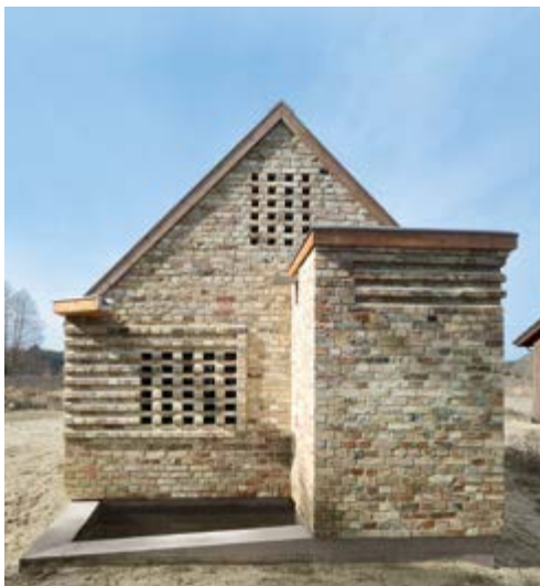
▲ Die äußere Gestalt deutet das Innere an: Das Regenbecken bildet ein Pendant zum Dusch-Risalit.
