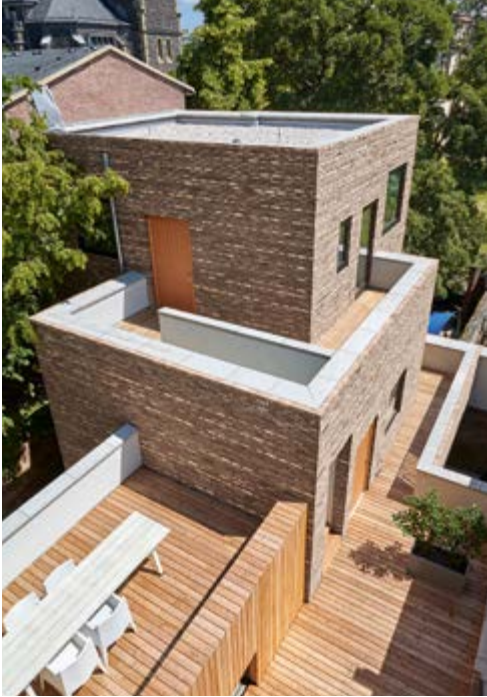
▲ Die großzügigen Dachterrassen werten auch den Bestand auf.
