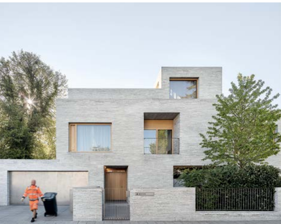
▲ Backstein und Massivholz verleihen dem Gebäude eine handwerkliche Präsenz.
