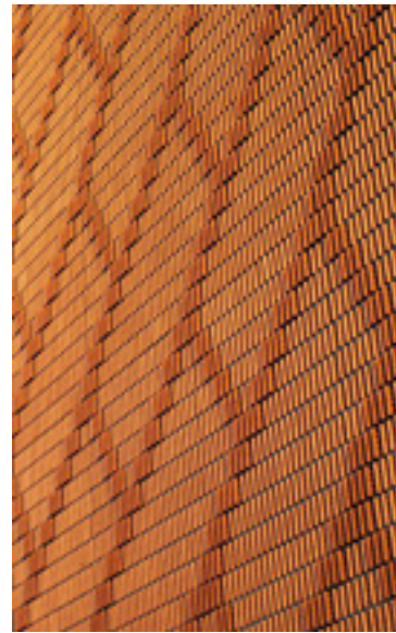
Fotos: © Heren 5 Architekten
