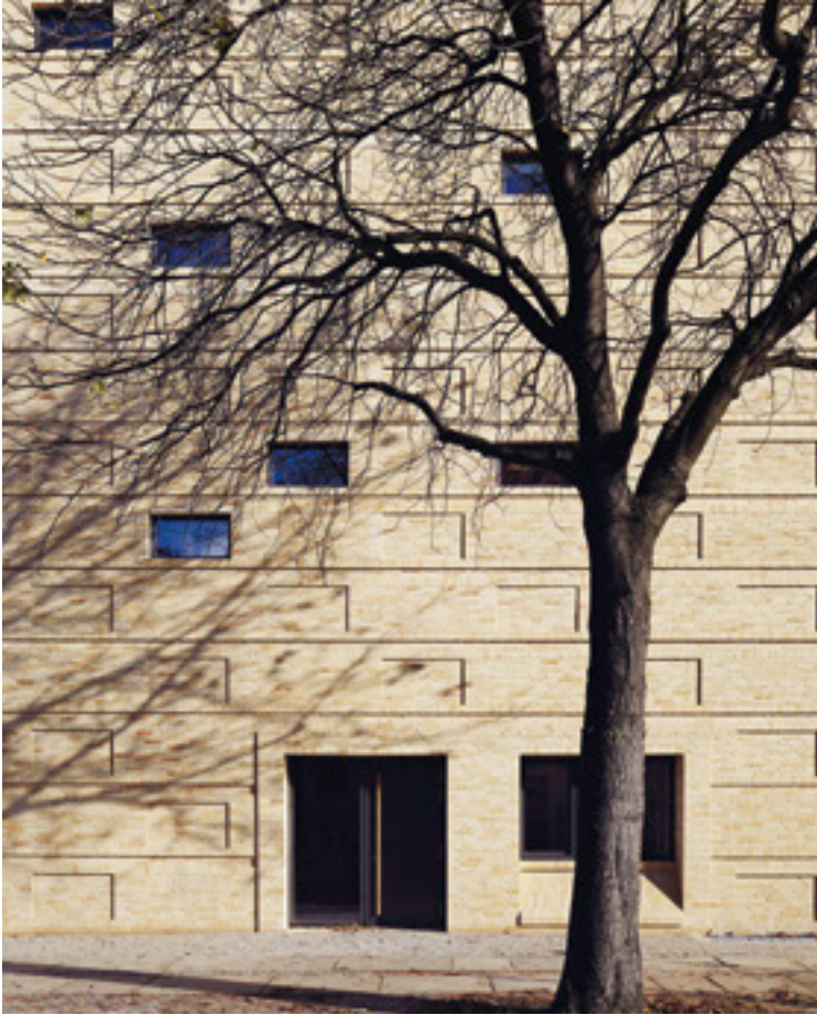
▲ Die helle Backstein-Fassade wurde skulptural behandelt.
