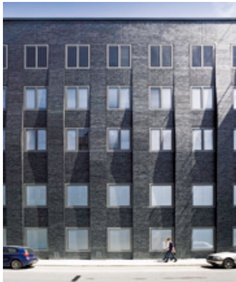
▲ Die neue Fassade gliedert sich in Brüstungen und Pfeiler.
