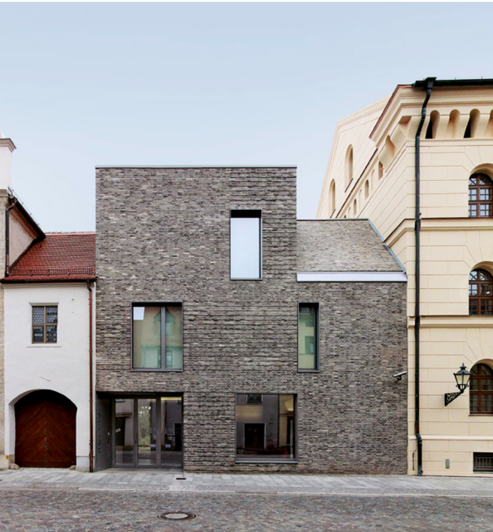
▲ Sensibel im historischen Umfeld verhält sich der Erweiterungsbau des Melanchthonhauses Wittenberg.
