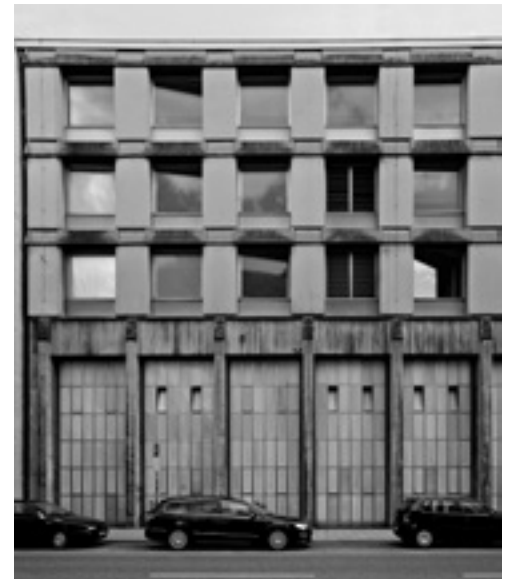
▲ Spröde Beton- und Rasterarchitektur der 1960er-Jahre an der alten Fassade.
