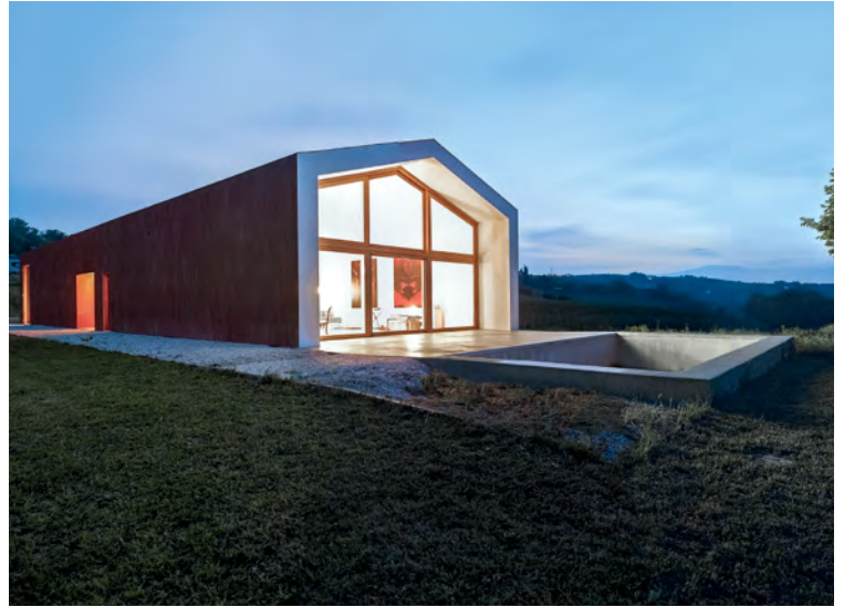
▲ Die komplette Giebelseite ist verglast – und leuchtet nachts ins weite Umland.
