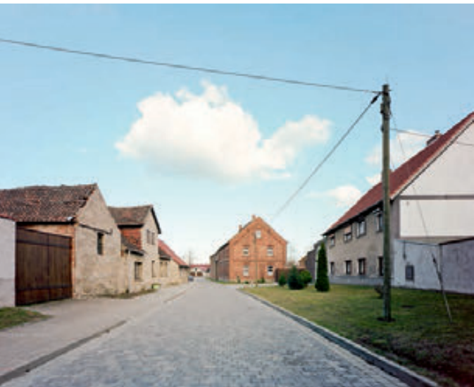
▲ Straßenansicht des Grundstückes: Der Umbau liegt in der zweiten Reihe.
