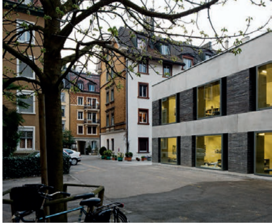
▲ Das monolithisch anmutende Gebäude kennzeichnet sich durch klare Geometrie.
