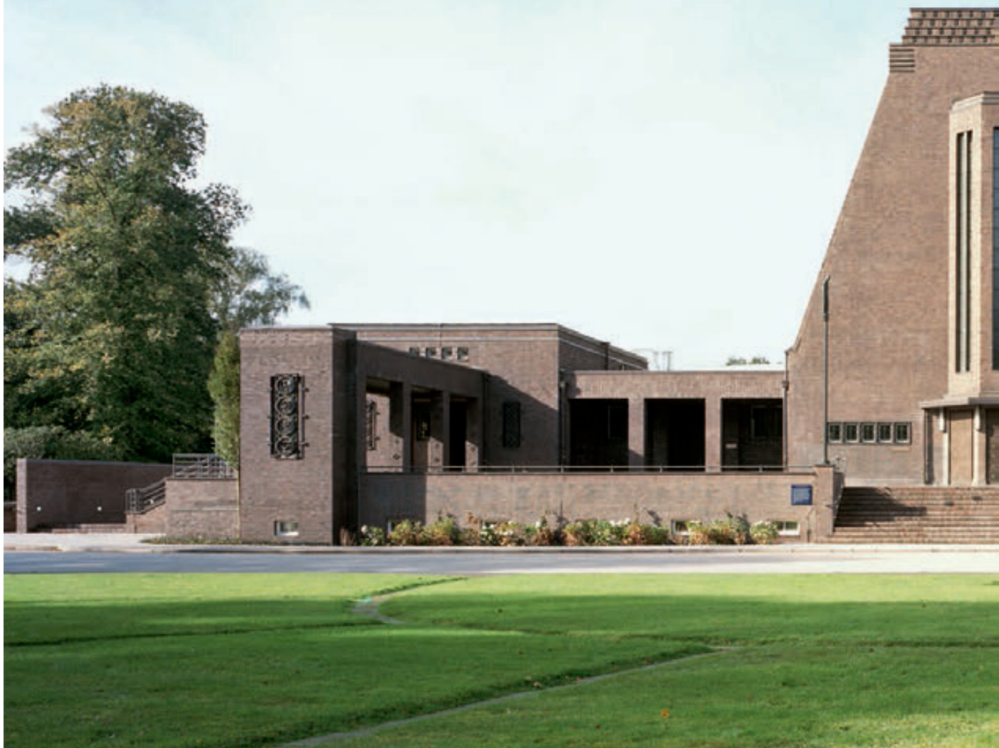
▲ Gesamtansicht der sanierten Fritz-Schumacher-Halle.
