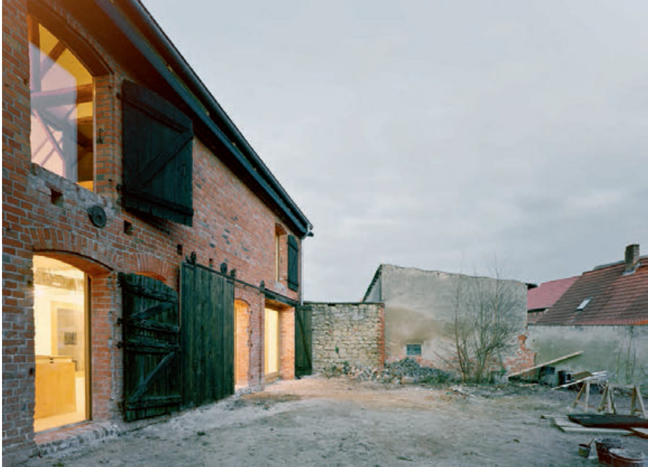
▲ Blick auf die Südfassade: Erst wenn Tore und Fensterläden geöffnet sind, zeigt sich der wahre Nutzungszweck der ehemaligen Scheune.
